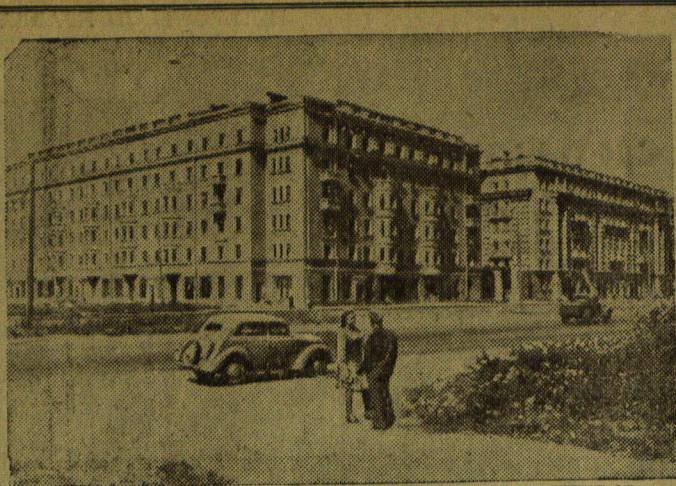
ЛЕНИНГРАД. На Московском шоссе широким фронтом ведутся работы по строительству жилых домов. Законченность которых была прервана в дни Отечественной войны. Находясь в непосредственной близости от линии фронта, район Московского шоссе был сильно разрушен. Теперь это один из наиболее благоустроенных районов города. На снимке: здания на Московском шоссе. Фото Н. Караваева. Прессклише ТАСС.
